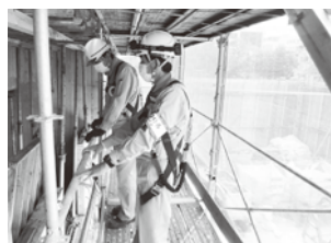
安全パトロールの様子
