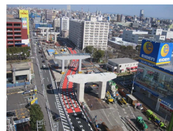
工事現場の様子
